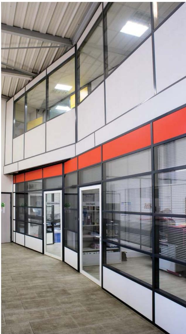
Cloisons M85 sur 2 niveaux associées à une plate-forme LP3.
