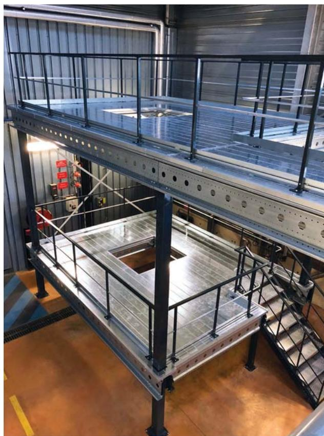
Plate-forme de maintenance PROPLUS LP3 sur 2 niveaux avec un plancher tôle.
