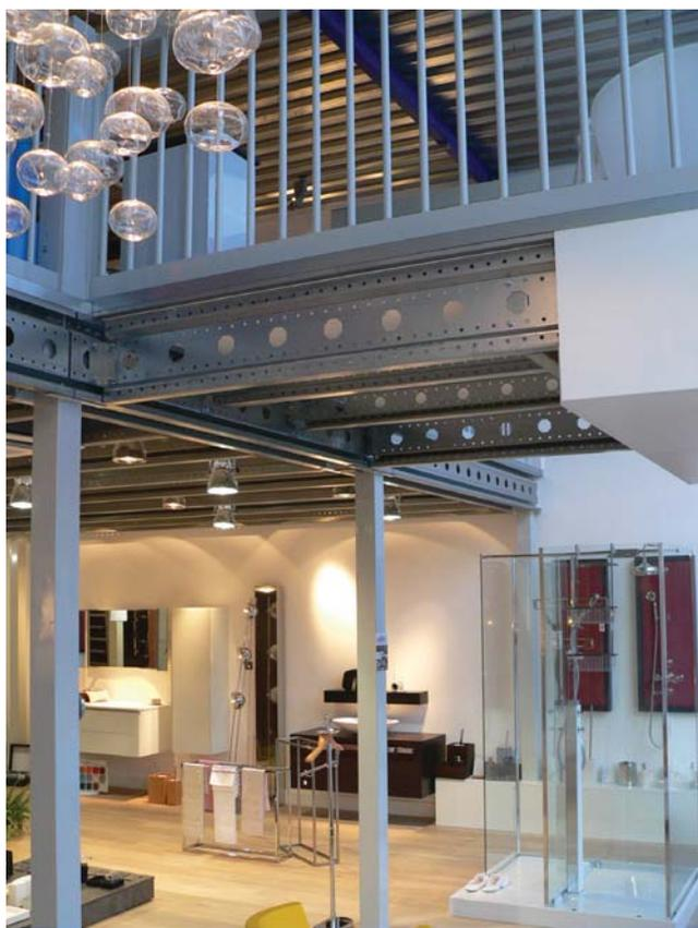
Plate-forme PROPLUS LP3 et garde-corps ERP en magasin.
