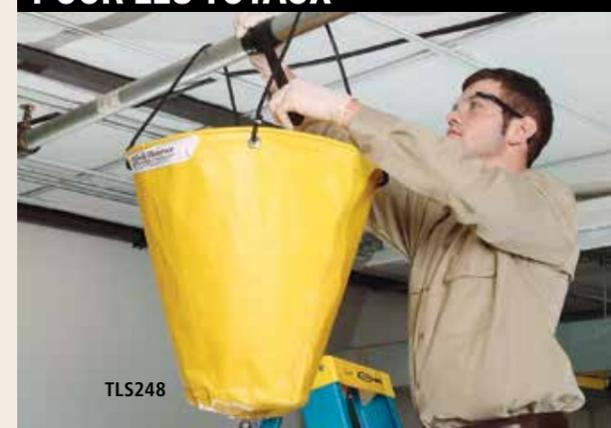
Les systèmes de dérivation de fuites de tuyaux PIG se suspendent facilement afin de détecter les fuites et de détourner les fuites et la condensation.
