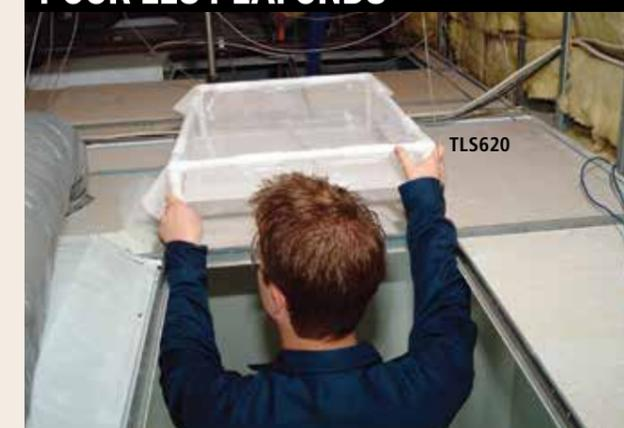
Les systèmes de dérivation pour les fuites de plafond PIG s'installent dans les zones du bureau pour une protection discrète qui ne gênera pas.
