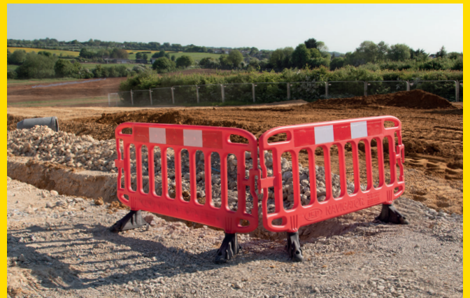
La barrière Navigator® balisant une zone à risque sur chantier.
